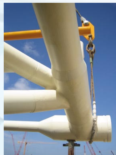
Vue en gros plan d'un nœud moulé (crédit photo Acergy)
